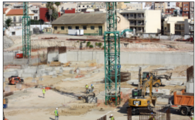
Trabajos de hormigonado en septiembre de 2010
