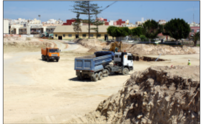
Fase de cimentación en julio de 2010
