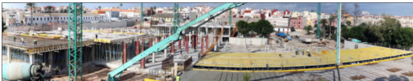
Panorámica de las obras del hospital desde una toma realizada desde el sur en diciembre de 2010
