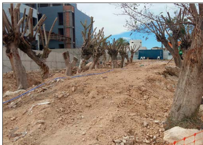
Retirada del arbolado de la parcela
