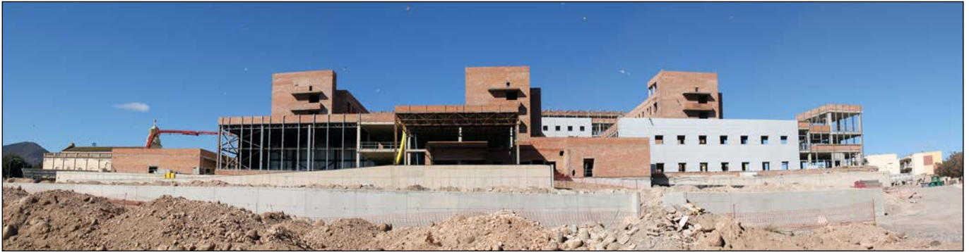
Parcela del nuevo hospital tras los derribos, acondicionamiento e instalación de saneamientos
