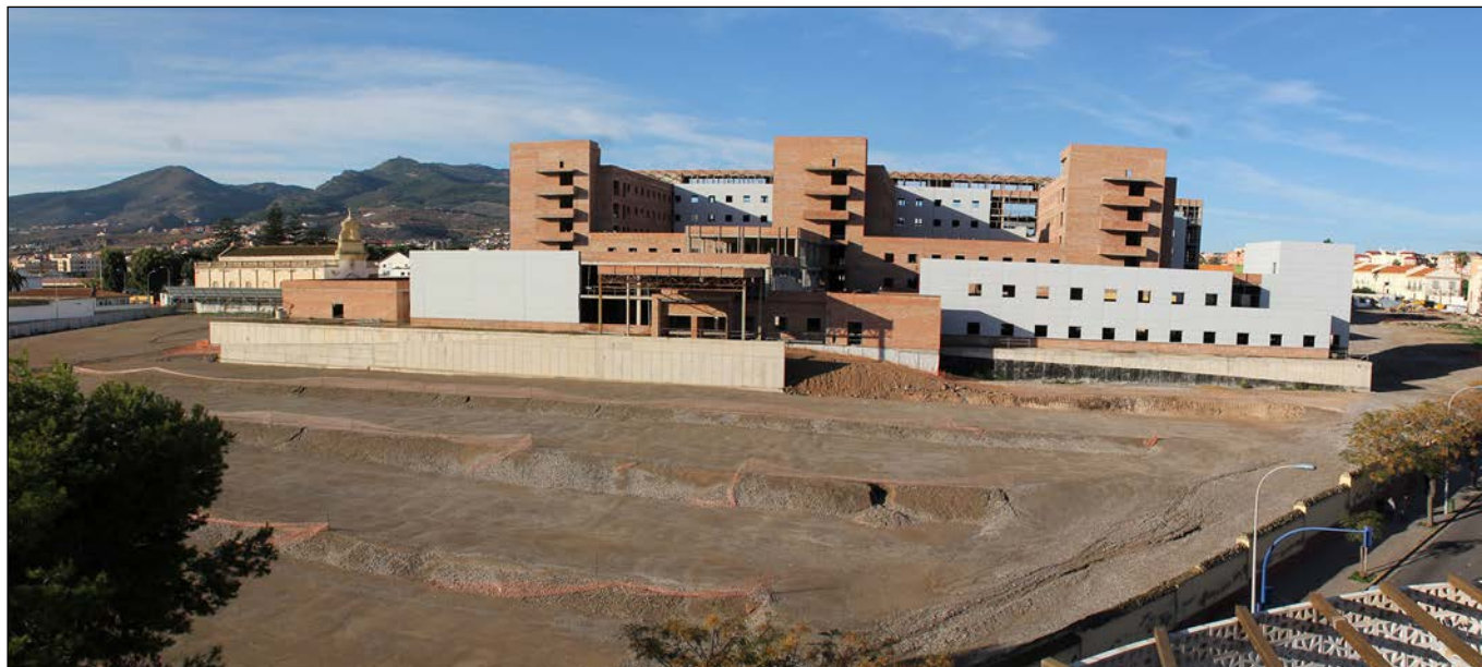
Estado de las obras el 2 de noviembre de 2018
