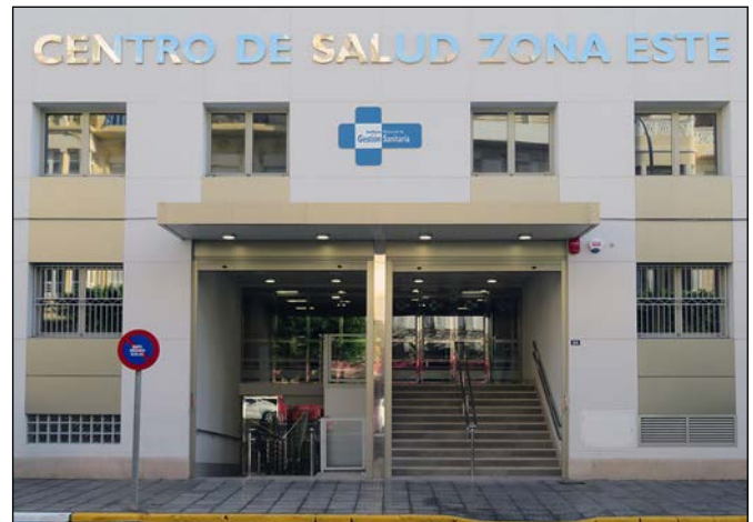
Centro de Salud de la Zona Este tras la reforma
