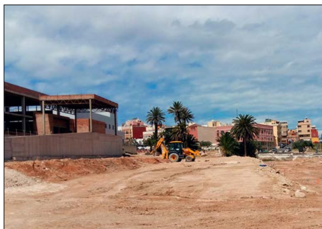
Trabajos de acondicionamiento de la parcela
