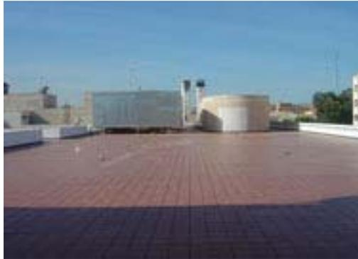
Con esta inversión se ha resuelto el problema de la existencia de goteras localizadas en ambos centros de salud y en la planta segunda del hospital. Para ello, se han sustituido íntegramente las cubiertas actuales por una nueva evitando una actuación parcial que no garantizaría el correcto funcionamiento de la misma, debido al mal estado en que se encontraba.
