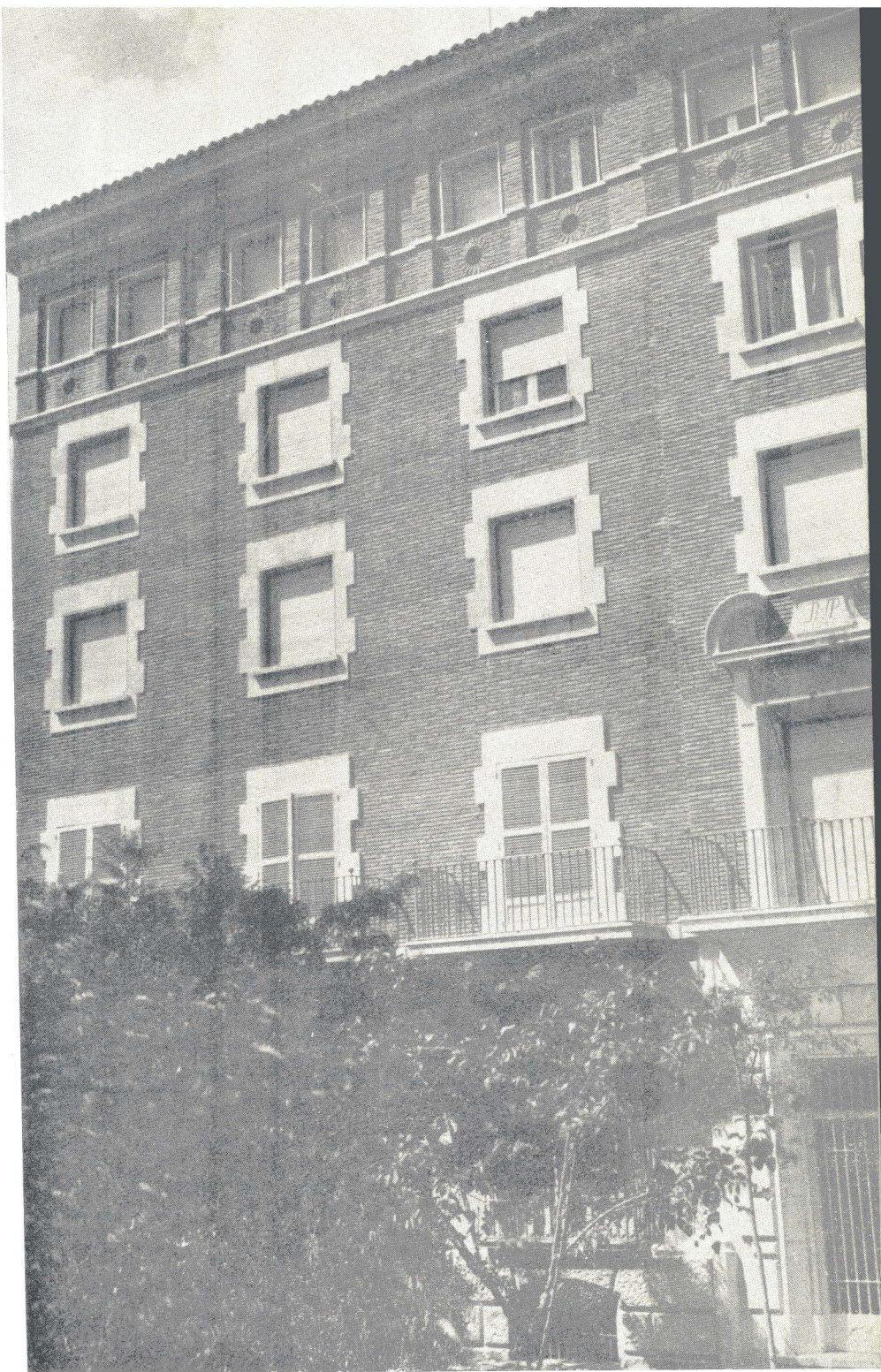
Fachada principal del edificio de la Delegación Provincial del Instituto Nacio de Previsión en Teruel.
