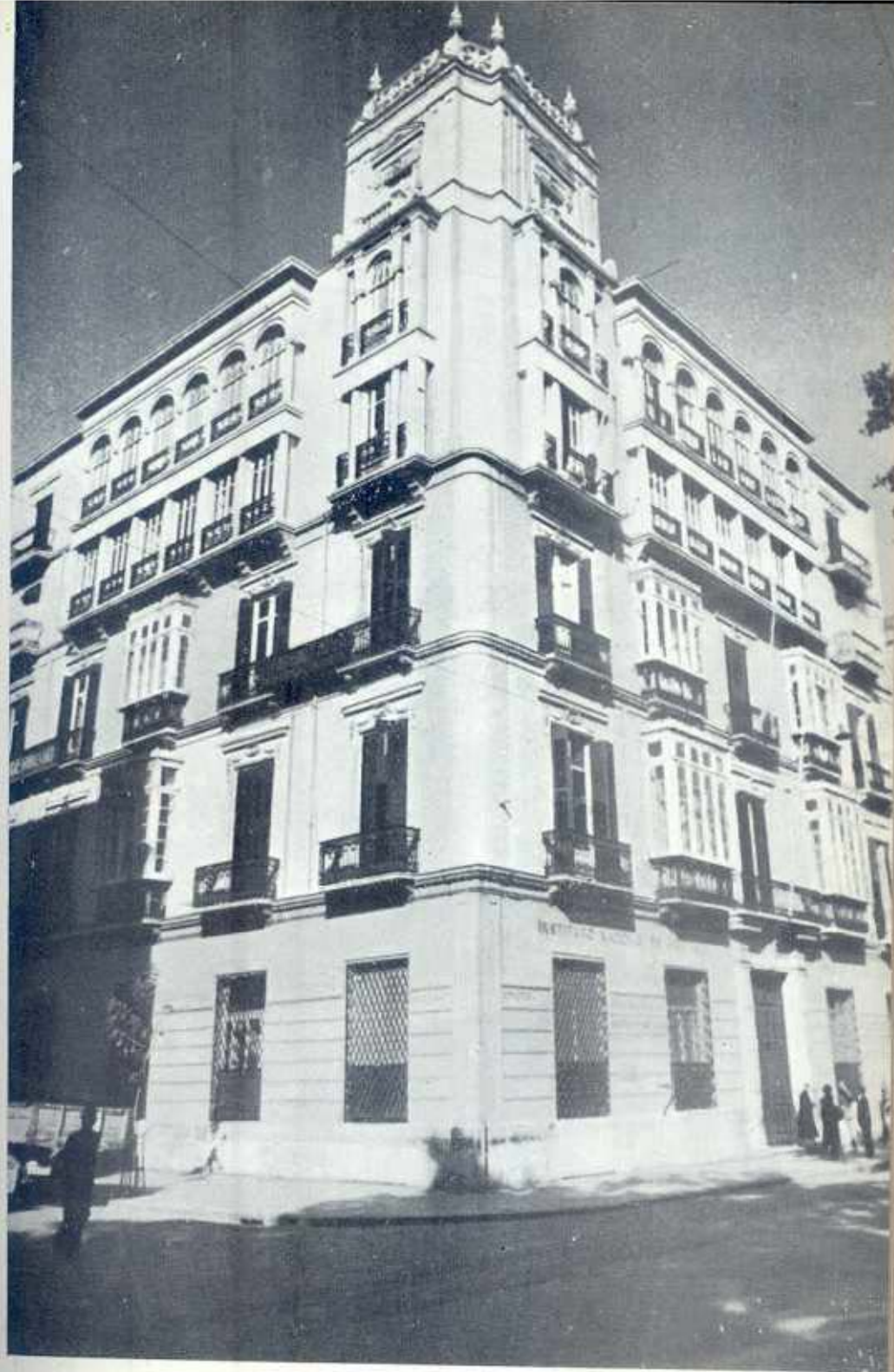
Edificio de la Delegación Provincial del Instituto en Málaga
