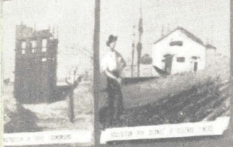
PROTECCIÓN DE LOS CONDOMINIOS
