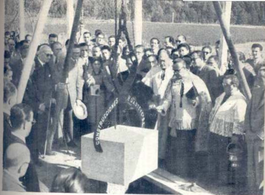
Colocación de la primera piedra de la Residencia Sanitaria de la C. N. S. E., de Zaragoza. Solar propiedad del I. N. P., sito en la prolongación de la Gran Vía.
