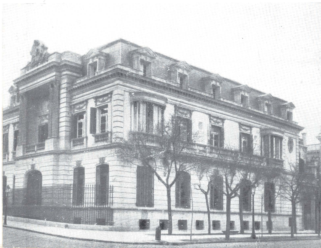
El nuevo edificio en que ha quedado instalada la Sede Central del Instituto.
