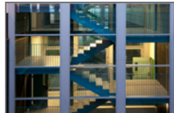
Núcleo de escaleras.
