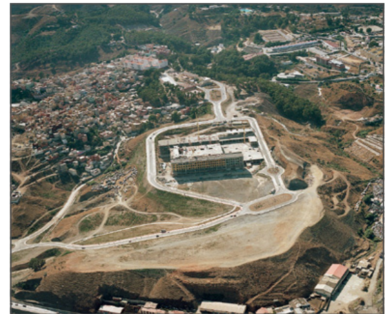
Desmontes realizados en Loma Colmenar
