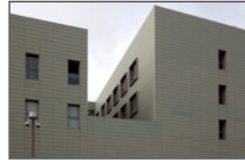
Fachadas. Revestimiento cerámico.
