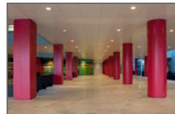
Zona porticada. Acceso al Hospital.
