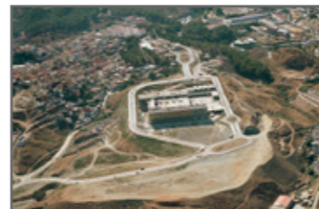
Desmontes realizados en Loma Colmenar.
