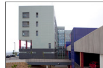
Exterior lateral edificio hospitalización.
