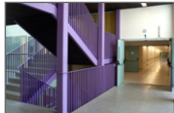
Núcleo de escaleras.
