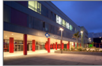
Zona porticada. Acceso al Hospital.
