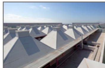
Cubiertas del edificio central.
