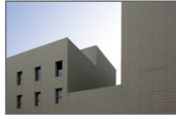
Fachadas. Revestimiento cerámico.
