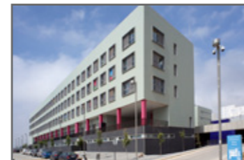
Bloque de hospitalización.
