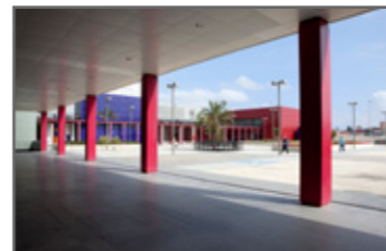
Zona porticada. Acceso al Hospital.
