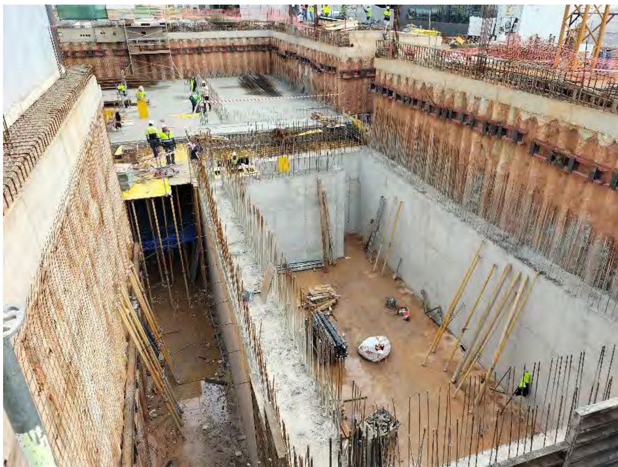
Fotografía de las obras del nuevo Centro Nacional de Dosimetría
