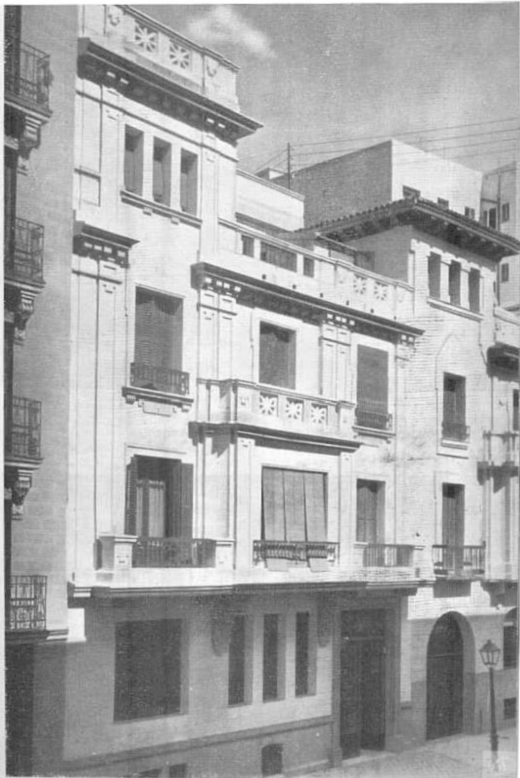
Clinica que la Obra Maternal e Infantil del Instituto Nacional de Previsión posee en Madrid, en la calle de Covarrubias, núm. 30.
